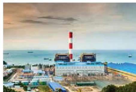
Vung Ang 1 Thermal Power Plant
